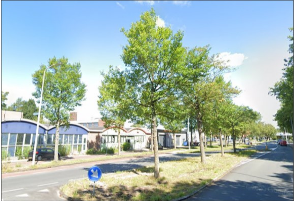
Afbeelding: de Dr. H.G. Scholtenstraat ter hoogte van het plangebied, met links een deel van de huidige bebouwing ter plaatse van het plangebied (bron: www.google.nl/maps )
