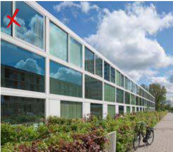
Te weinig articulatie van de woningen onderling.
