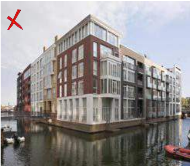
Bouwblok is opgesplitst in uiteenlopende architectonische eenheden.
