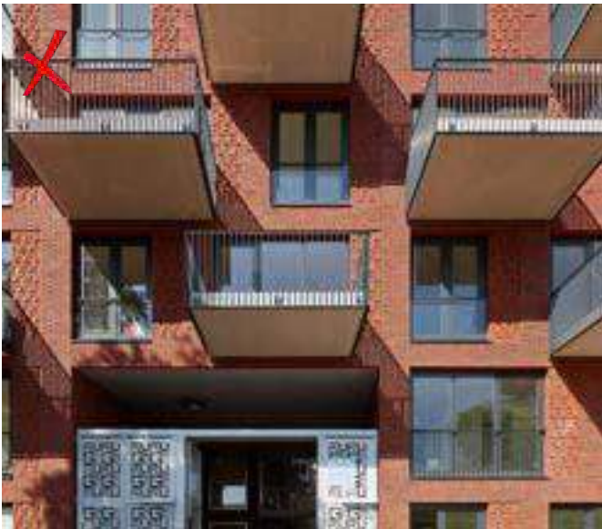
Uitstekende balkons als losse elementen aan de gevel.
