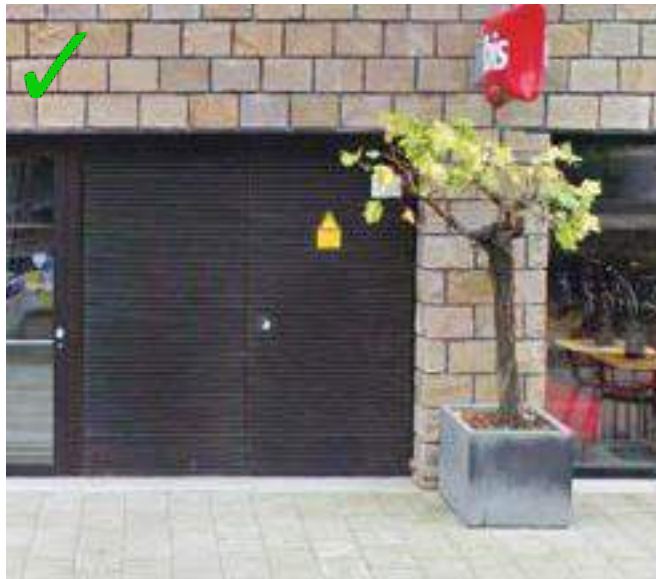
Noodzakelijke techniek is passend opgelost in de gevel.
