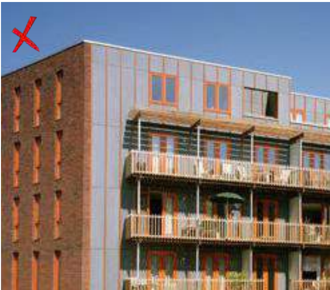
De galerij als toegevoegd losstaand element.
