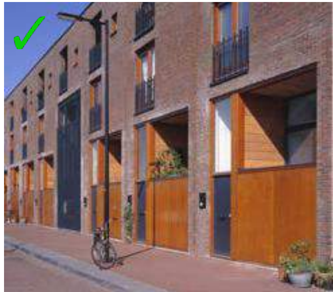
Bebouwing staat in de rooilijn en definitieert de straat.
